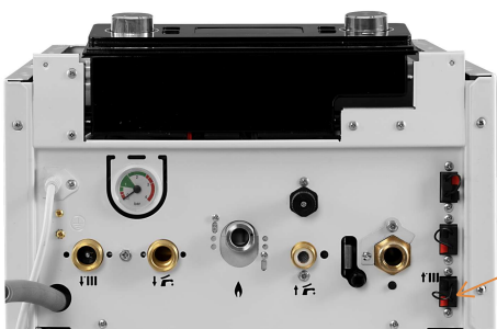
Клеммы 1 и 2 разъема "ДНТ"
